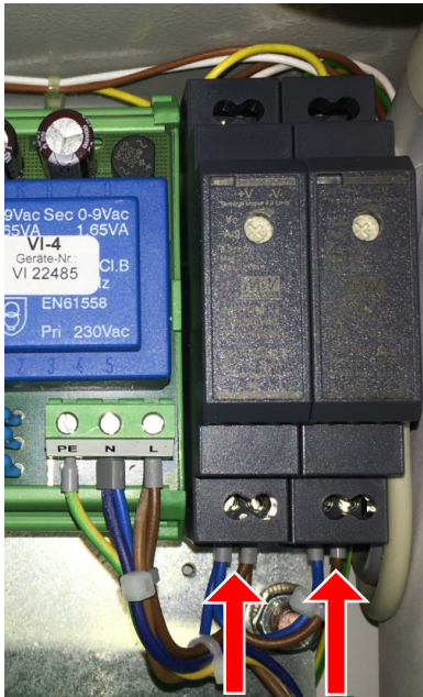
Abbildung 20: Fixierung Netzteile
