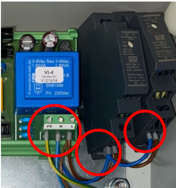
Abbildung 18: Stromversorgungskabel Netzteile
